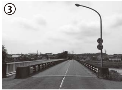
③ 亀山白山線(亀山橋)照明灯更新事業
