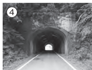
④ 金場トンネル修繕事業(関町金場)
