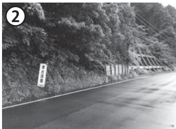
② 国道25号災害防除事業(関町新所)
