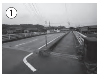
① 野登橋橋梁修繕事業(辺法寺町)
