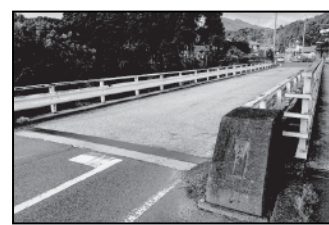
④一般国道25号板屋橋 橋梁耐震対策事業 (加太板屋)
