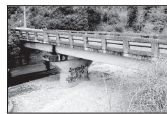
③一般国道25号大和橋 橋梁耐震対策事業 (関町新所)
