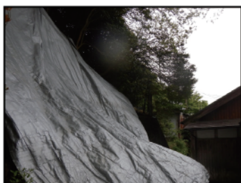
1 坂下2地区 急傾斜地崩壊対策事業 [関町坂下]
