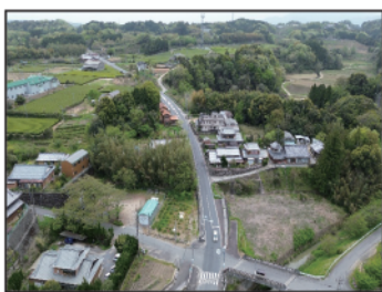
1 亀山停車場石水溪線 歩道整備事業 [辺法寺町]
