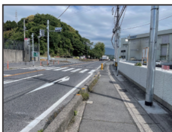
3 国道 306 号線 防護柵設置事業 [長明寺町]
